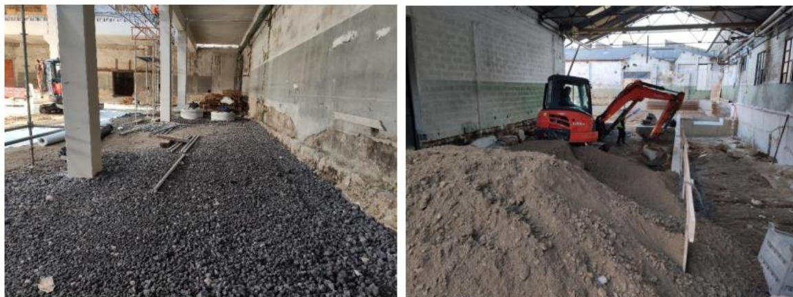
Figura 4 – Fotografias da obra do armazém de matérias-primas e novos cais de carga (Fonte: EIA, abril de 2025)
